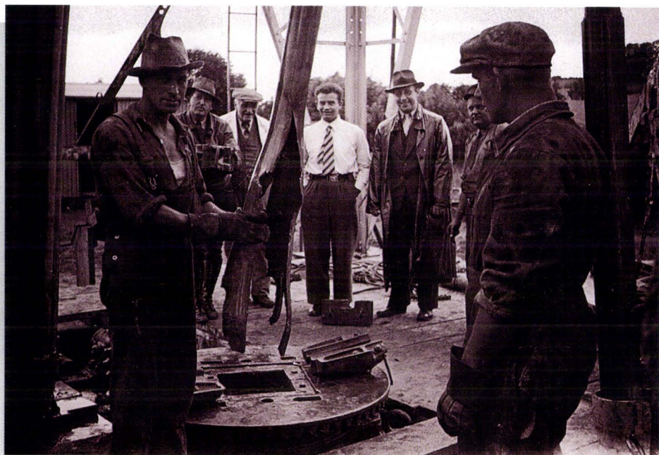
Fig. 1. I perioden 1935 - 37 blev der ved Harte vest for Kolding udført 2 efterforskningsboringer. Det var de første forsøg på at finde olie i Danmark. Den første boring nåede en dybde på 794 meter og sluttede i kridt aflejringer. Den anden boring nåede 1099 meter, og kom derved gennem kridtet og ned i lerede aflejringer fra trias perioden. Ved en boring anvendes meget tungt udstyr, det er derfor ikke usædvanligt, at der opstår uheld under arbejdet. Også under boringerne ved Harte skete uheld. På billedet ses at borestammen af stål er revet fra hinanden.
